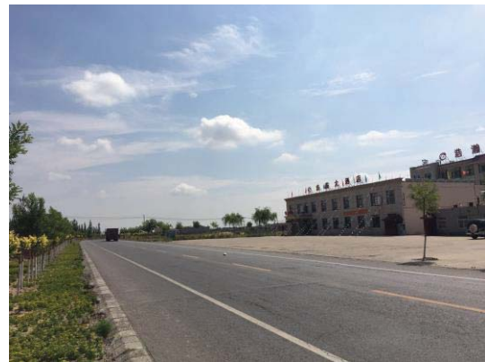
拟建项目南侧榆补路
