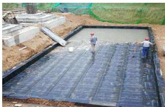
防水层的水泥砂浆保护层施工
