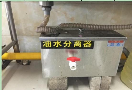
图 3-1 油水分离器现场照片
