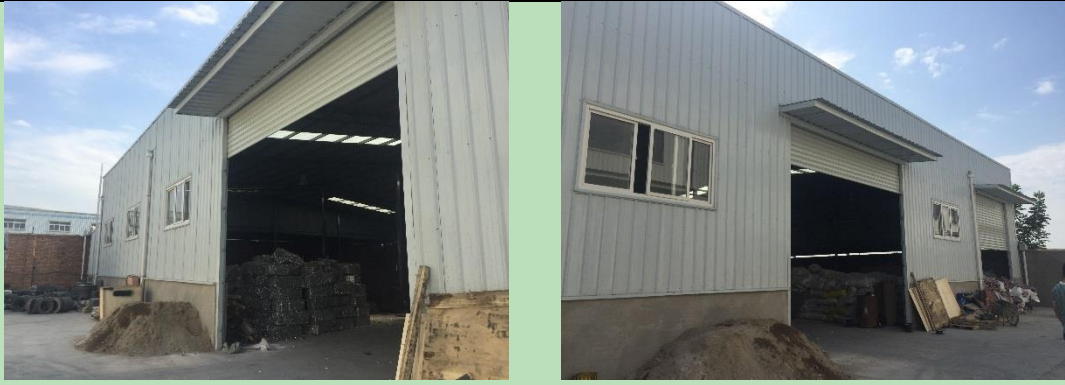
一般工业固体废物暂存间
