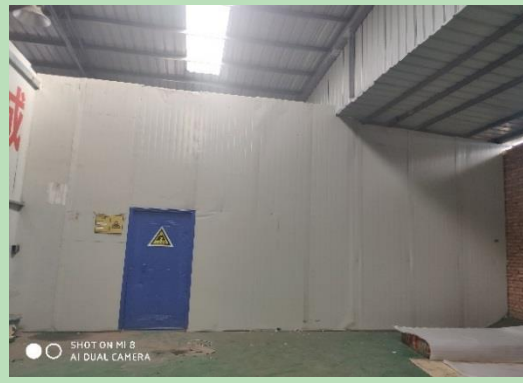
危险废物暂存间（外观）
