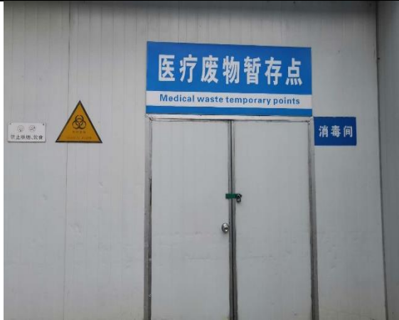
医疗废物暂存间
