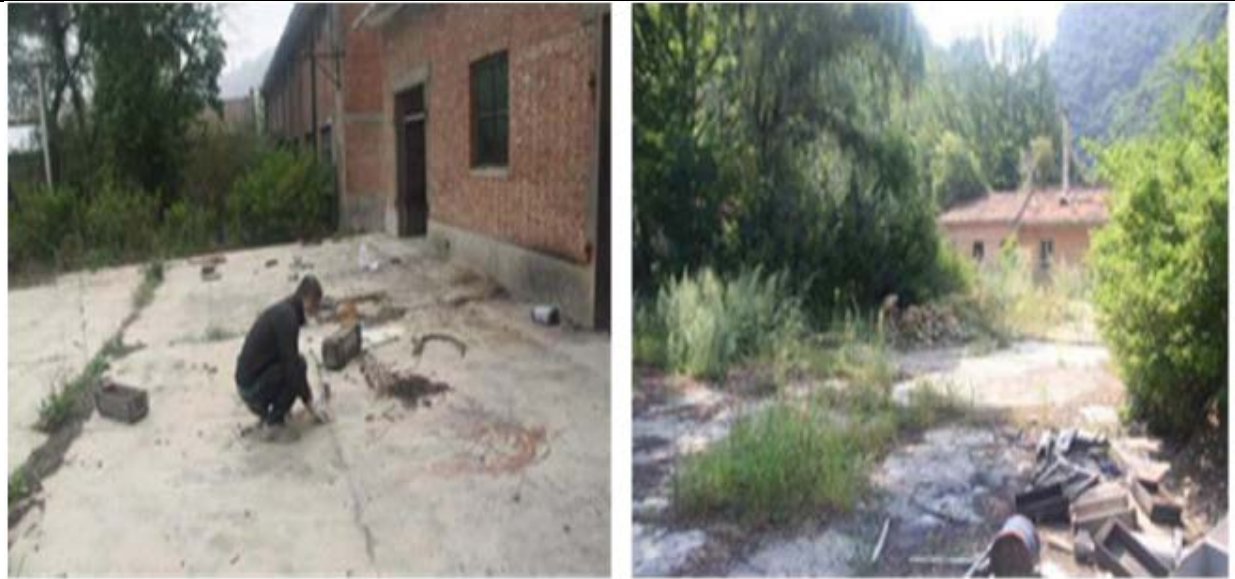
照片 9-5 治理前室外地面、路面抛洒现场照片
