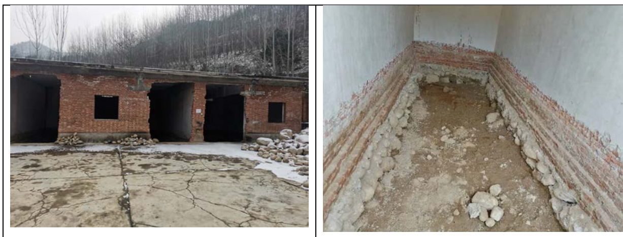
照片 9-7 库房开挖后现场照片
