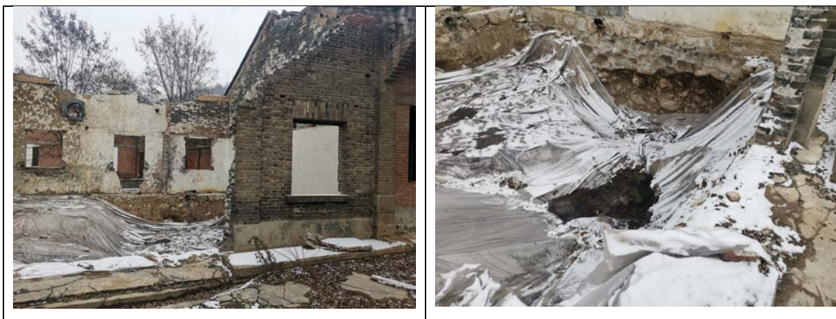
照片 9-11 裂变室开挖后现场照片
