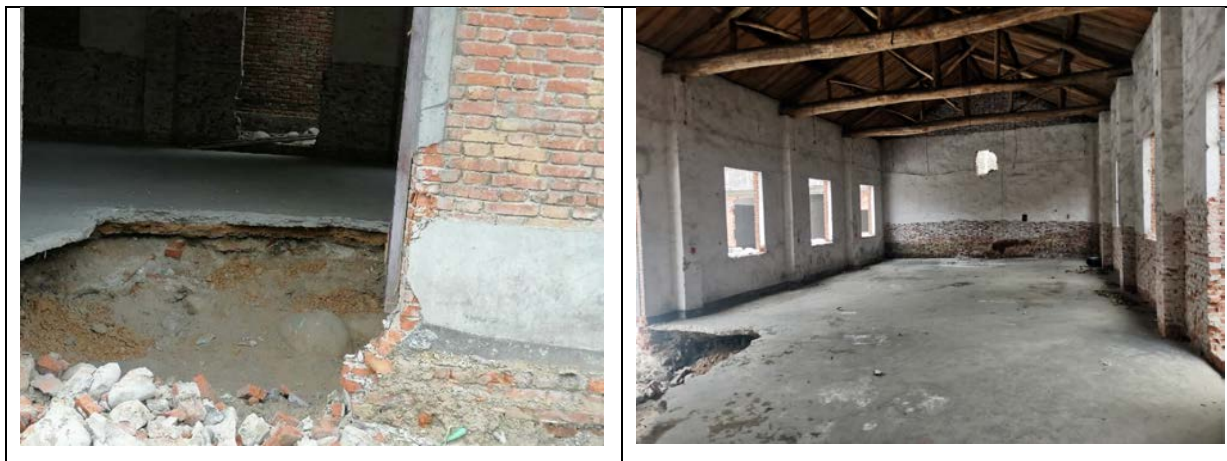
照片 9-6 拉丝车间开挖后现场照片
