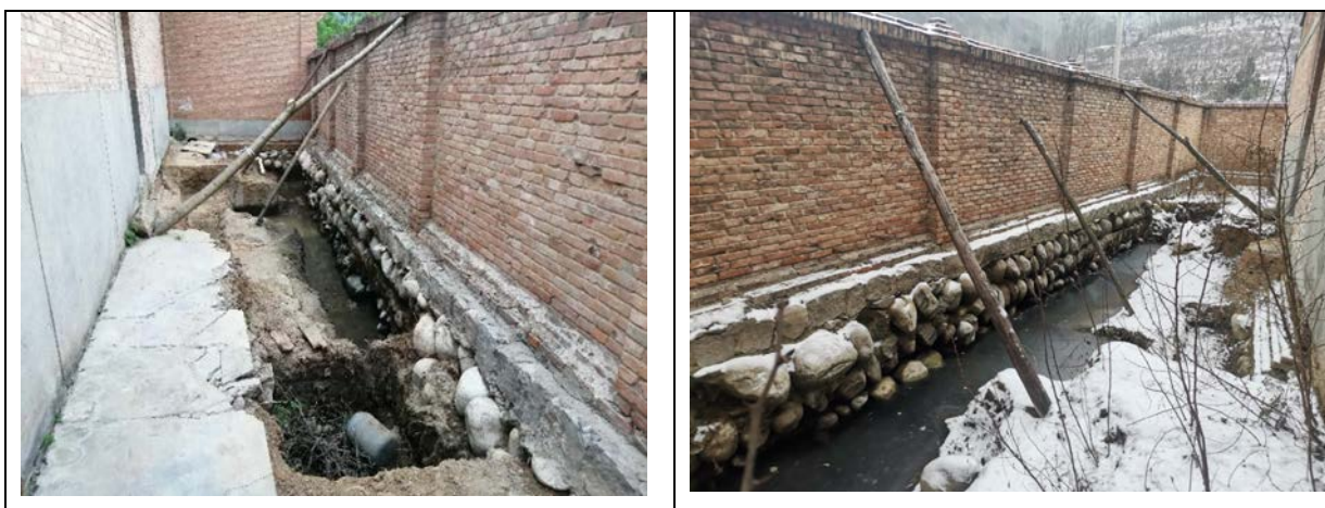
照片 9-10 粉末车间北侧开挖后现场照片
