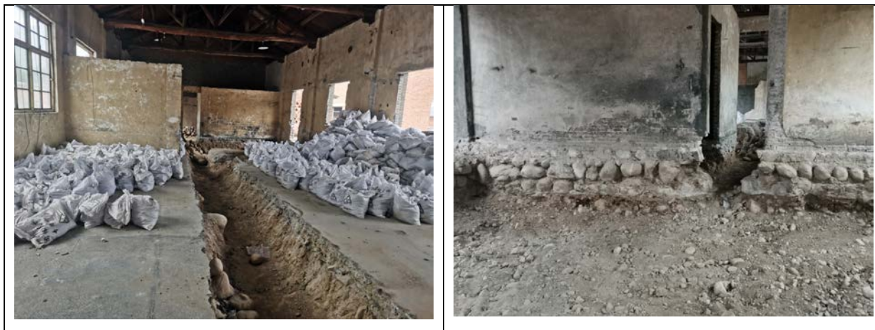
照片 9-8 锤熔、油压车间开挖后现场照片
