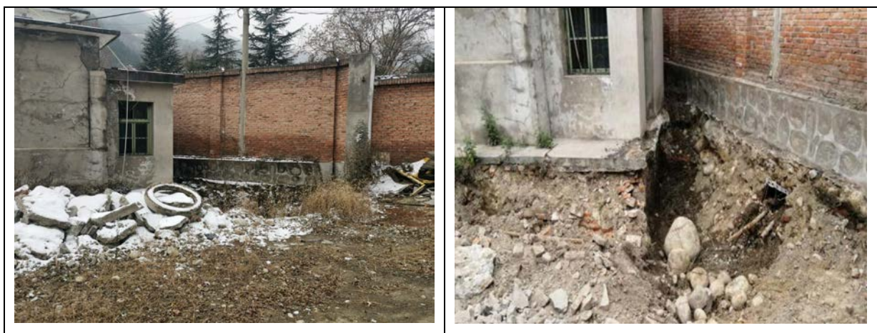
照片 9-9 浴室北侧开挖后现场照片
