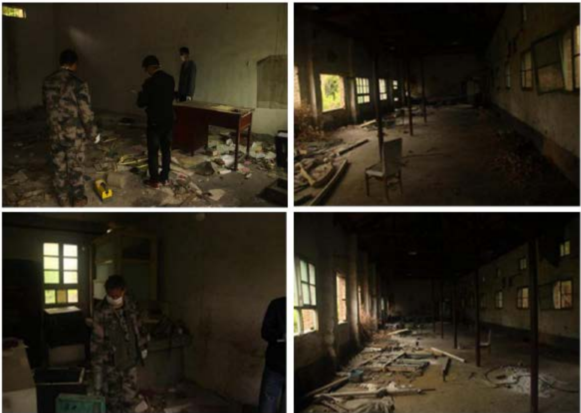
照片 9-1 治理前太白县钨制品厂建（构）筑物内部现状照片
