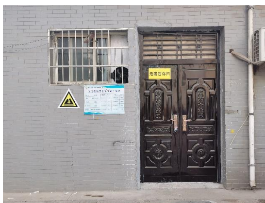
危险废物暂存间
