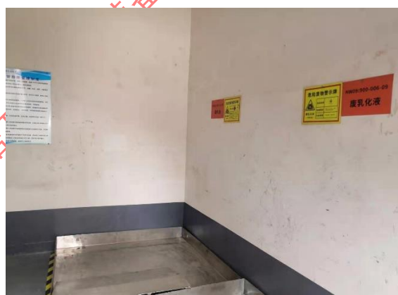
危险废物暂存间标识
