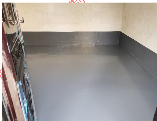
危险废物暂存间地面
