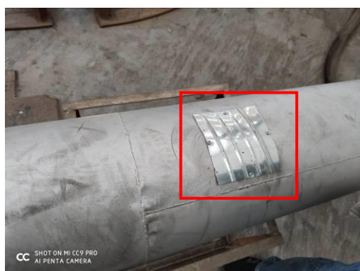
废气处理设施进口监测孔
