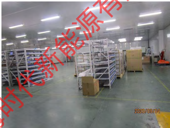
南侧 待安装设备
