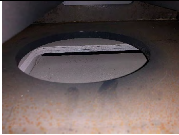
图 10-6 底部自然进风位置示意图
