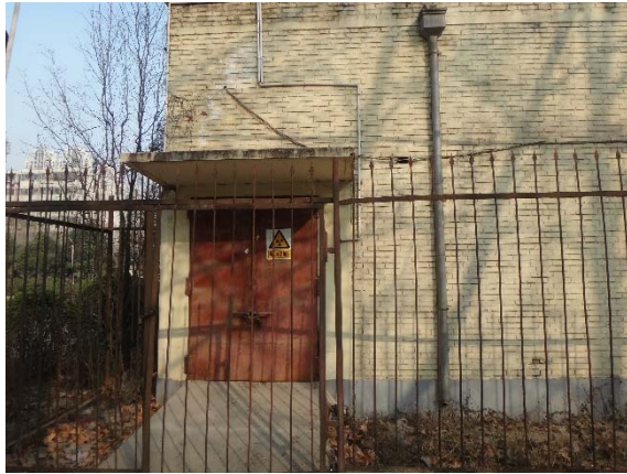
河南同新公司放射源库外的电离辐射警告标识
