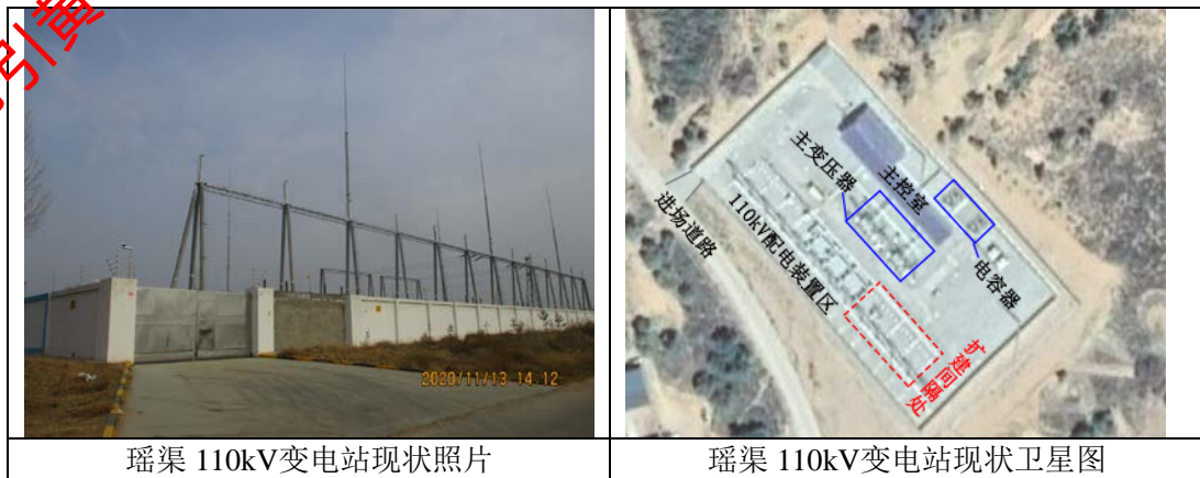
图2-2 瑶渠110kV变电站现状图
