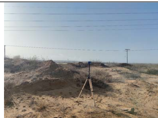
线路起点110kV西双线“ \pi ”接点
