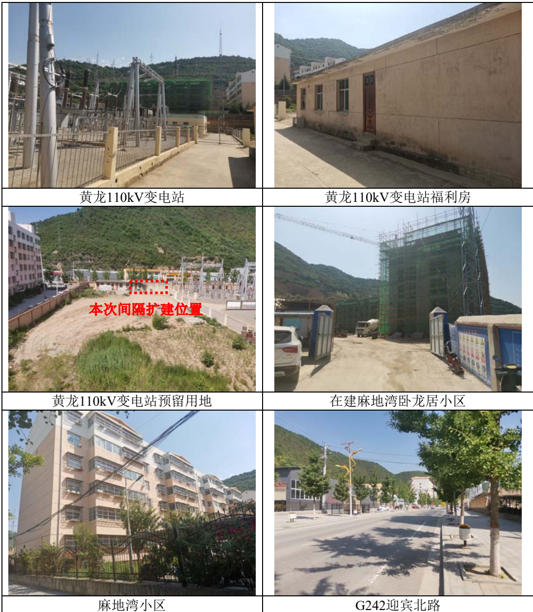
图2-2 黄龙110kV变电站现状及周边环境照片
