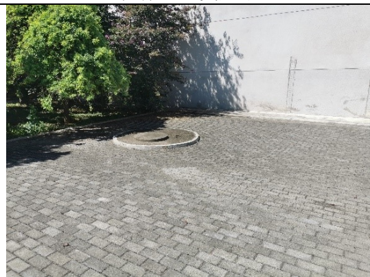
现有事故油池
