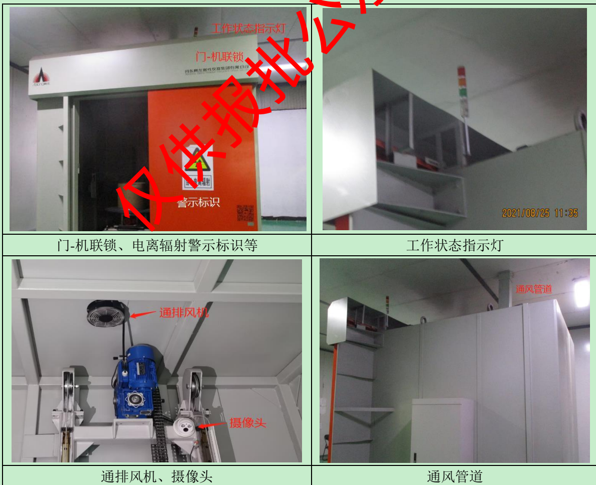
图 10-3 铅房防护设施示意图
