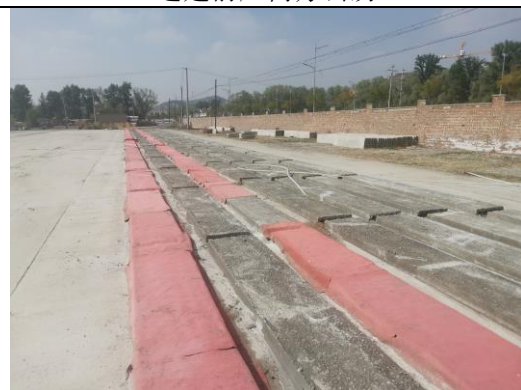
迁建前厂内楼板生产堆放区
